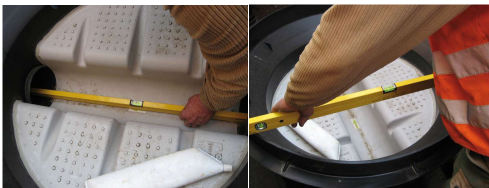
Slika 3 i 4: Kontrola položaja odvoda
