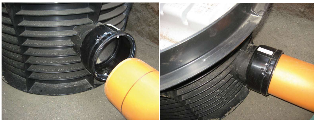
Slika 5 i 6: Izvođenje spoja šahta sa PVC cijevima
