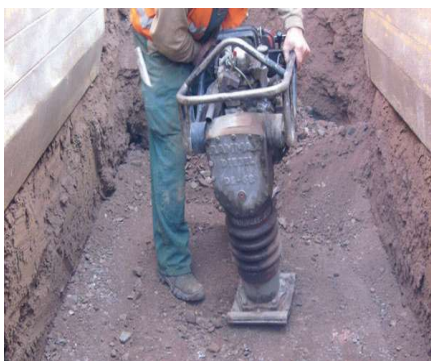
Slika 1 i 2: Priprema podloge za polaganje šahтова
