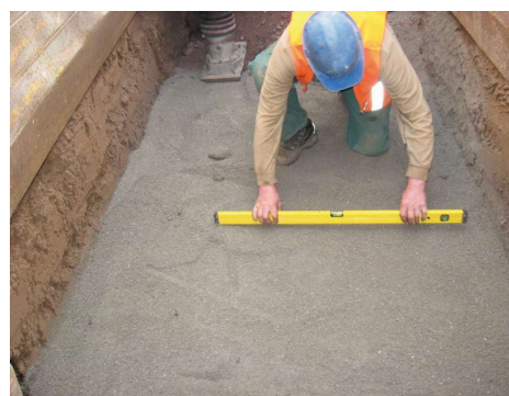
Slika 1 i 2: Priprema podloge za polaganje šahтова
