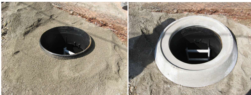
Slika 9 i 10: Postavljanje betonskog prstena za prihvatanje opterećenja
